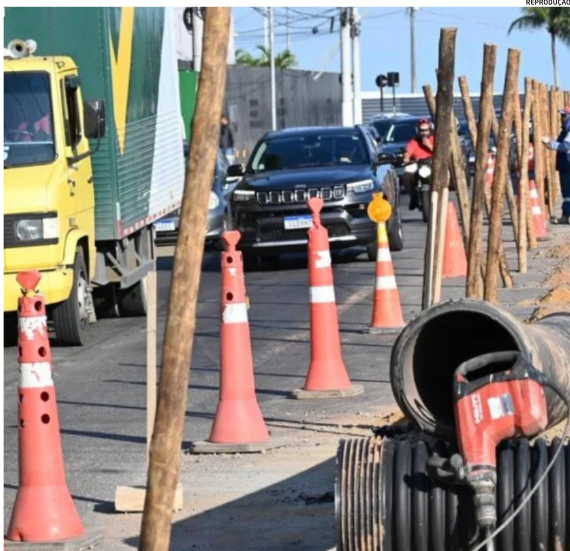
Obras do Mergulhão, em Vitória, têm atrasado o deslocamento de quem depende da Norte-Sul
