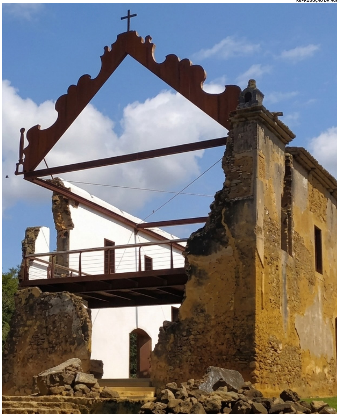
As ruínas de Queimado, importante monumento de resistência à escravidão no ES, foram restauradas
