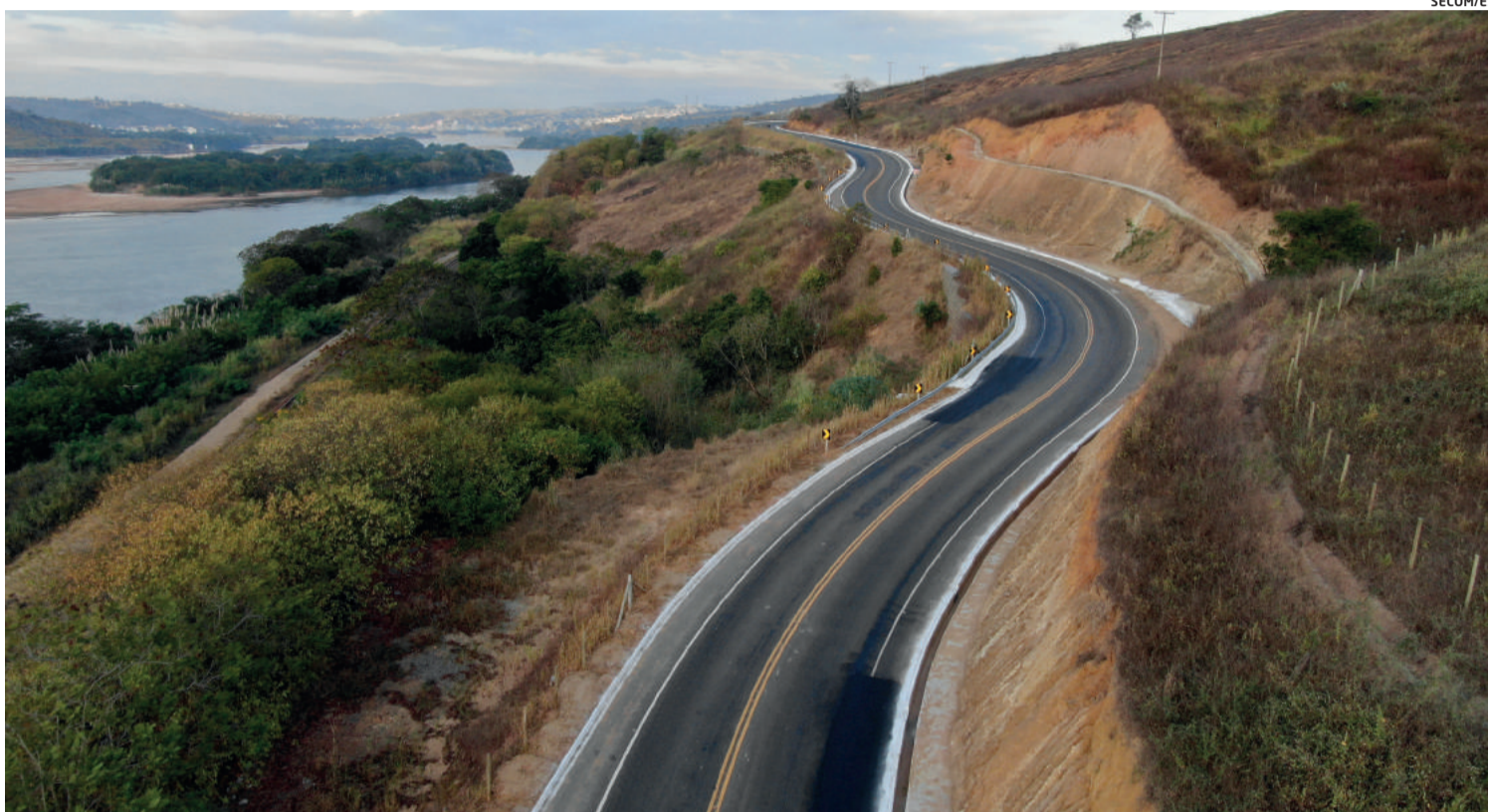
Foram entregues 15,6 km com drenagem, pavimentação, abrigos de ônibus, além de duas pontes e obras de contenção na ES-446
